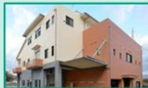
汚泥再生工場
