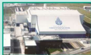
ごみ焼却発電施設
