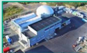
バイオガス工場
