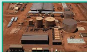
排水処理施設
