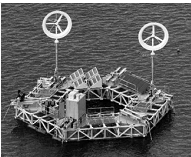
図-7 海上設置後の浮体発電施設
