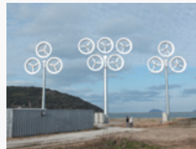
マルチレンズ風車(数10kW) 経産省・NEDO PJ
